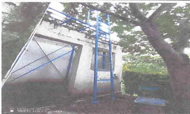
Foto1: suministro e instalación de estructura metálica y rotoplas para distribución de agua en sanitarios
