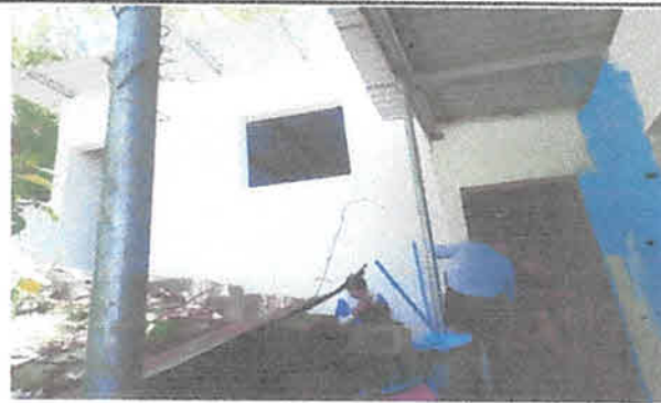
Foto 2: Ampliación de paredes de block para cocina
