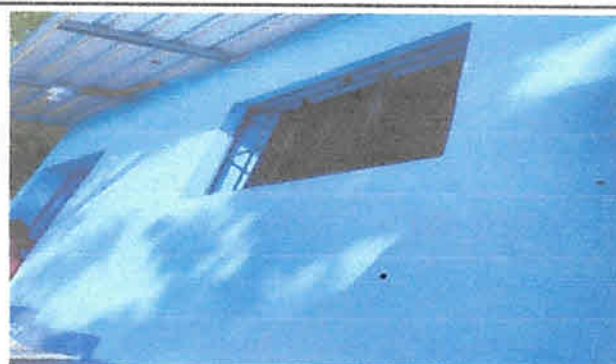
Foto 4: Aplicación de pintura en áreas interiores y exteriores de la Escuela
