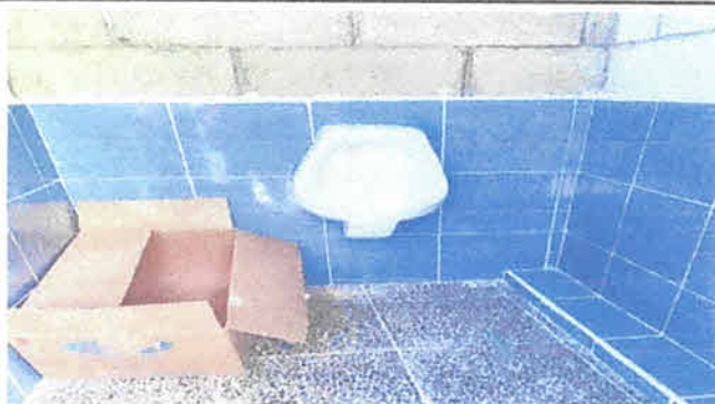
Foto 3: suministro e instalación de puerta para sanitario y mijitorio
